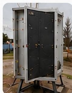
INSTALLATIONS SUR CHANTIER
