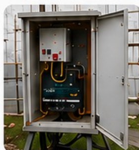
ARMOIRES DE DISTRIBUTION
